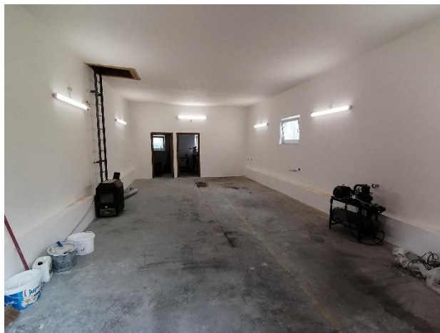
Nové elektrorozvody, osvětlení, podhledy a přívod vody
